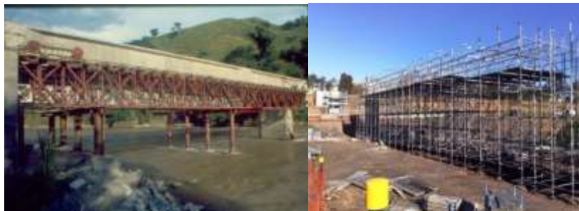
Imagen 5. Ejemplo de formaleta para construcción de superestructura
