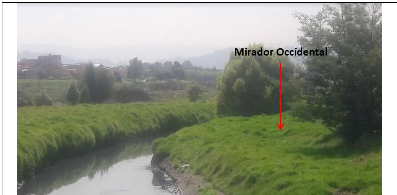
Fotografía 1. Ubicación aproximada del Mirador Occidental, según indicaciones de la EAAB en terreno.
